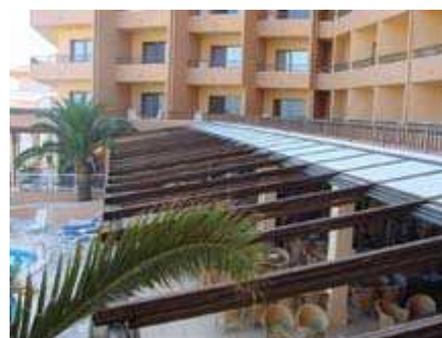
Il sistema delle coperture motorizzate è composto da una struttura modulare in profilati di alluminio di grandi sezioni quali travi, ancoraggi a muro, canale di gronda e colonne di sostegno. Il movimento avviene grazie ad una tecnologia che garantisce la massima precisione. Il sistema è disponibile sia in profilo normale sia a taglio termico, con isolamento ottenuto per mezzo di interposizione di materiale isolante tra i vari profilati.
